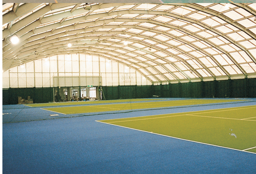
インドアテニスコート施工(テント構造)
